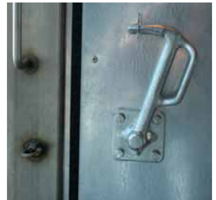
Scheunentor bis ins Detail: Zum Schließen der Fenster wird ein Torriegel genutzt
