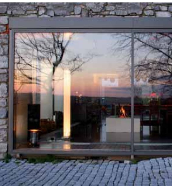
Fenstertüren aus Glas und Stahl
